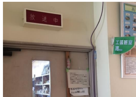
放送室が作業室に転用中
