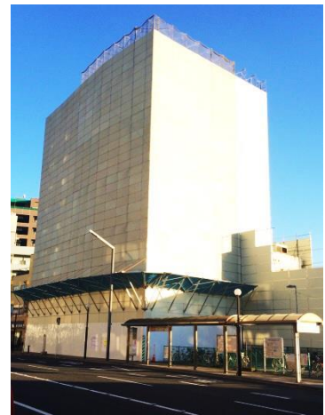
解体工事の飛散防止壁が組まれたたかみビル
