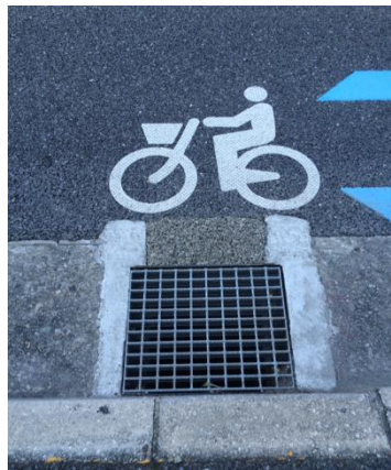
新しく付け替えられたグレーチング 堺市の自転車レーン
