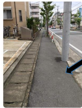
北栄2丁目にて撮影 傾斜の歩道に側溝がある
